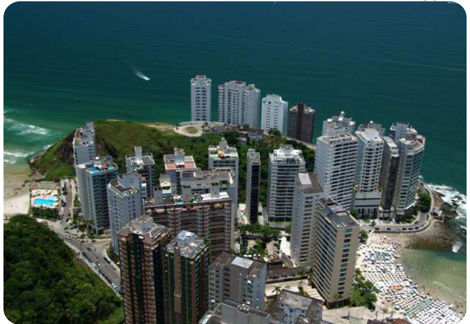
Vista aérea dos imóveis em Guarujá
